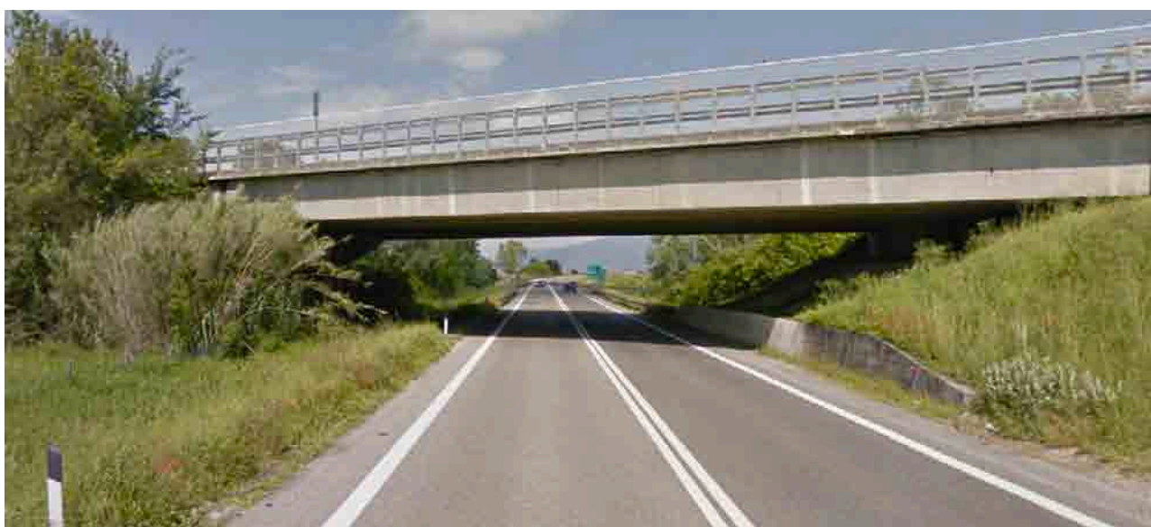
Figura 5 - STATO DI FATTO
