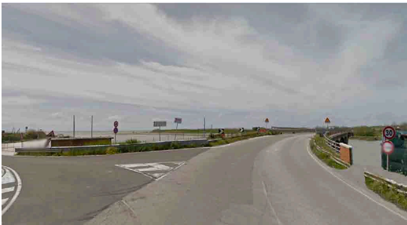
Figura 10 - STATO DI FATTO
